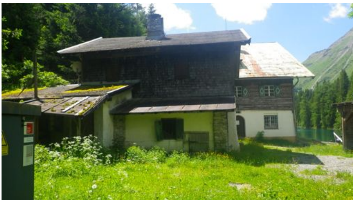
Abbildung 3: Der Platz im Norden ist in sich geschlossen und gegen Süden (Gebäude) wie gegen Norden und Osten (Waldkulisse, hier nicht zu sehen), abgegrenzt. Blick Richtung Süden.
