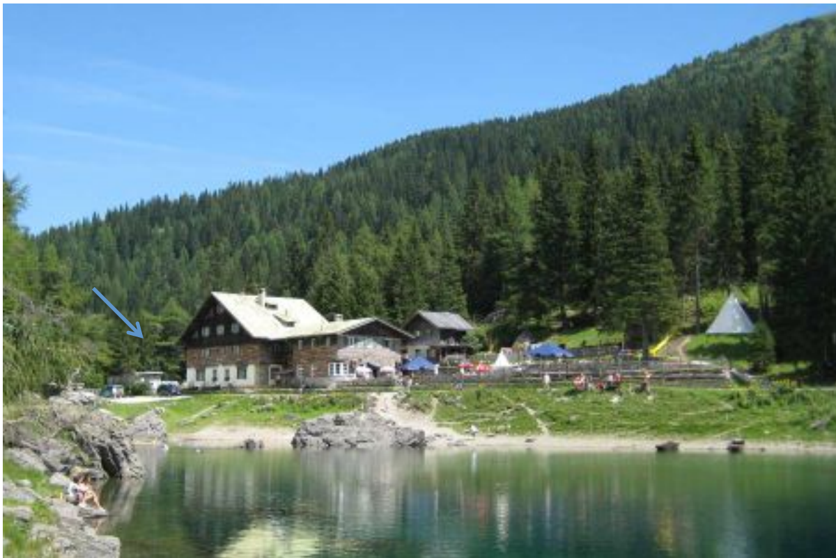
Abbildung 5, aus dem Internet, Nutzung mit Gastgartenbetrieb. Höherer Baumbestand nördlich des Gasthofes (Pfeil) und daher optische Abgrenzung nach Norden zu.
