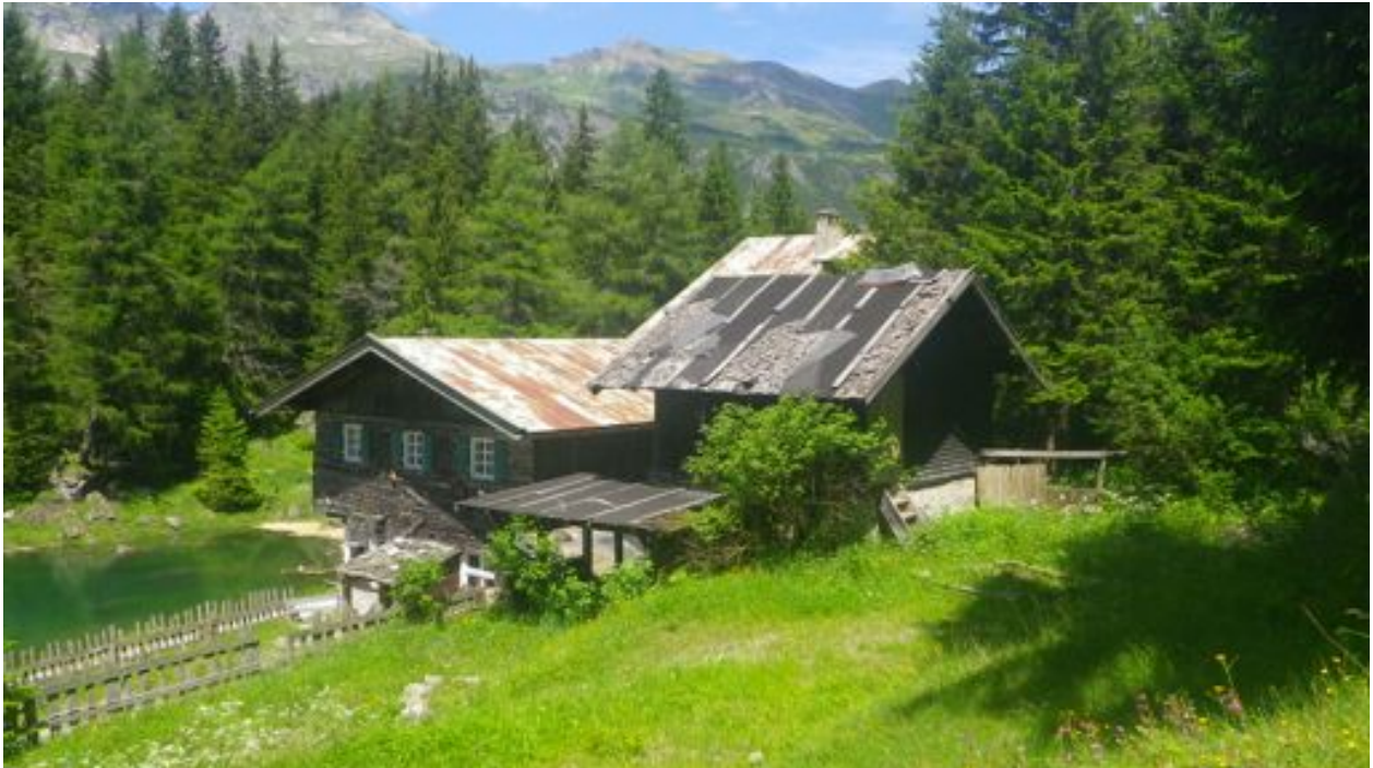
Abbildung 23: Klar lesbare, die Sehgewohnheiten nicht störende Szenerie. Die Gebäudegruppe steht ohne wesentliche Interventionen in traditioneller Konfiguration am weitgehend natürlich gebliebenen Hangfuß.
