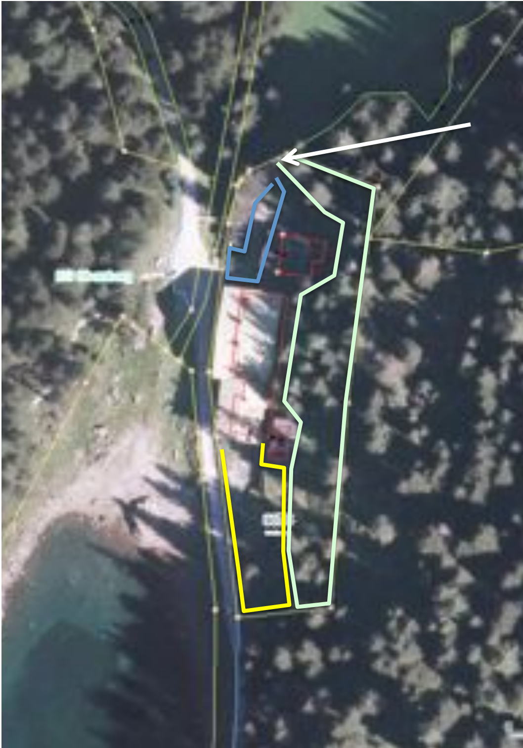
Abbildung 6: Orthofotoausschnitt (Quelle: Tiris) mit dem gegenständlichen Grundstück und dessen Raumgliederung. Die Böschung hinter dem Gebäude ist weitgehend natürlich strukturiert und natürlich bewachsen (grün). Der südliche Teil ist extensiv gärtnerisch gestaltet (gelb), während im Norden ein kleiner, geschotteter Platz für wirtschaftliche Zwecke (Lagerung, Garagierung) besteht. Der Pfeil weist auf die schmale Waldkulisse im Norden hin.
